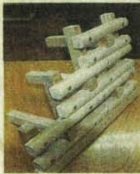
県内の小水路に試験導入された木製ブロックの河川護岸が、大津波を受けてもほとんど無傷だったことがわかった。もともとは間伐材の活用や生態系への配慮が目的で導入。コンクリート製の護岸にも負けない機能に注目が集まっている。
