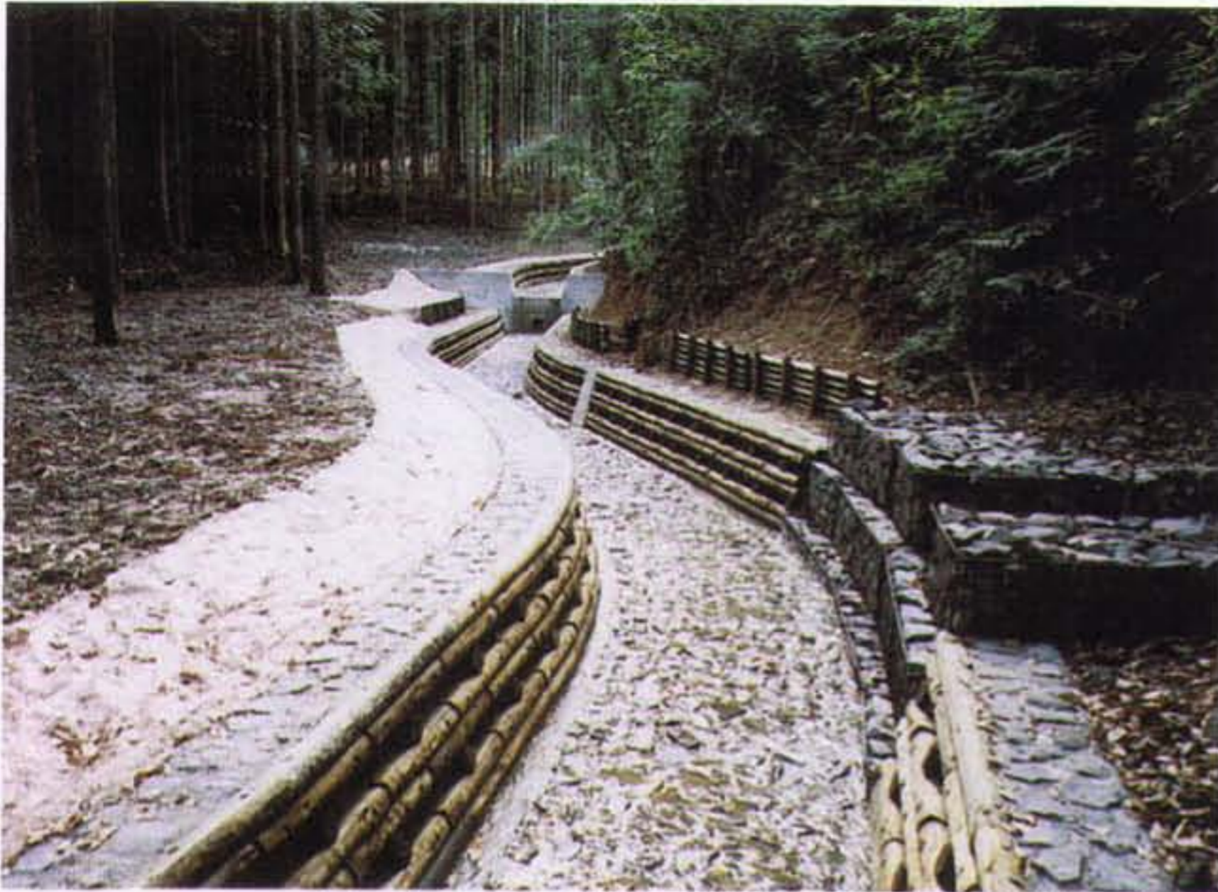
▲ウッドブロックを使用した水路工（施工地／愛媛県久万高原町）
