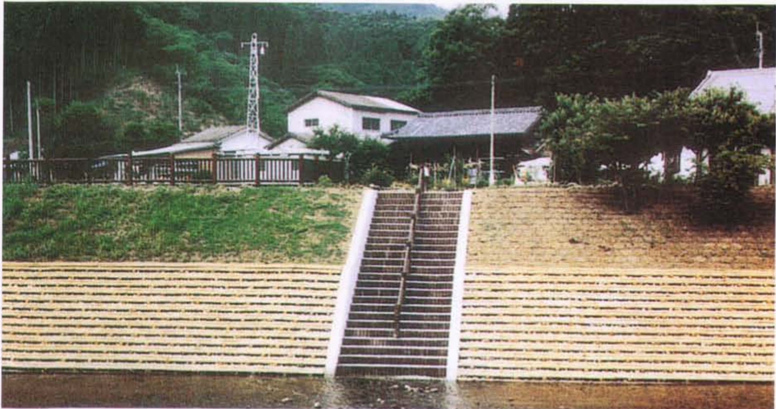
▲河川の護岸に使用したウッドブロック積（施工地／宮崎県門川町）
