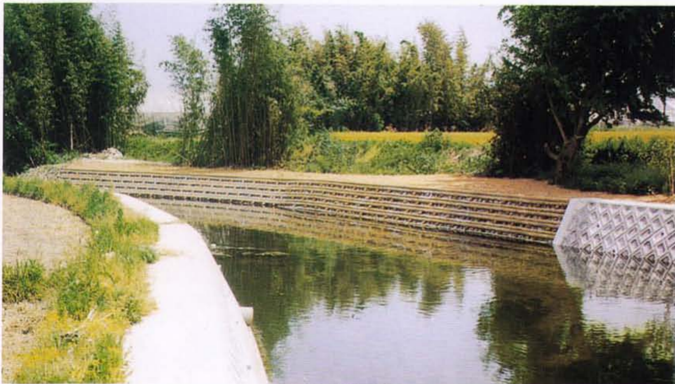
▲河川の護岸に使用したウッドブロック積（施工地／福岡県八女市）
