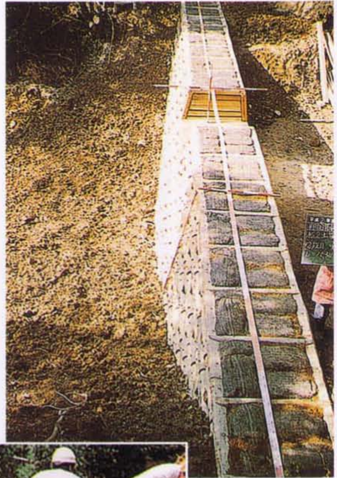
▲多目的保安林事業に使用したウッドブロック積（施工地／愛媛県西予市）
