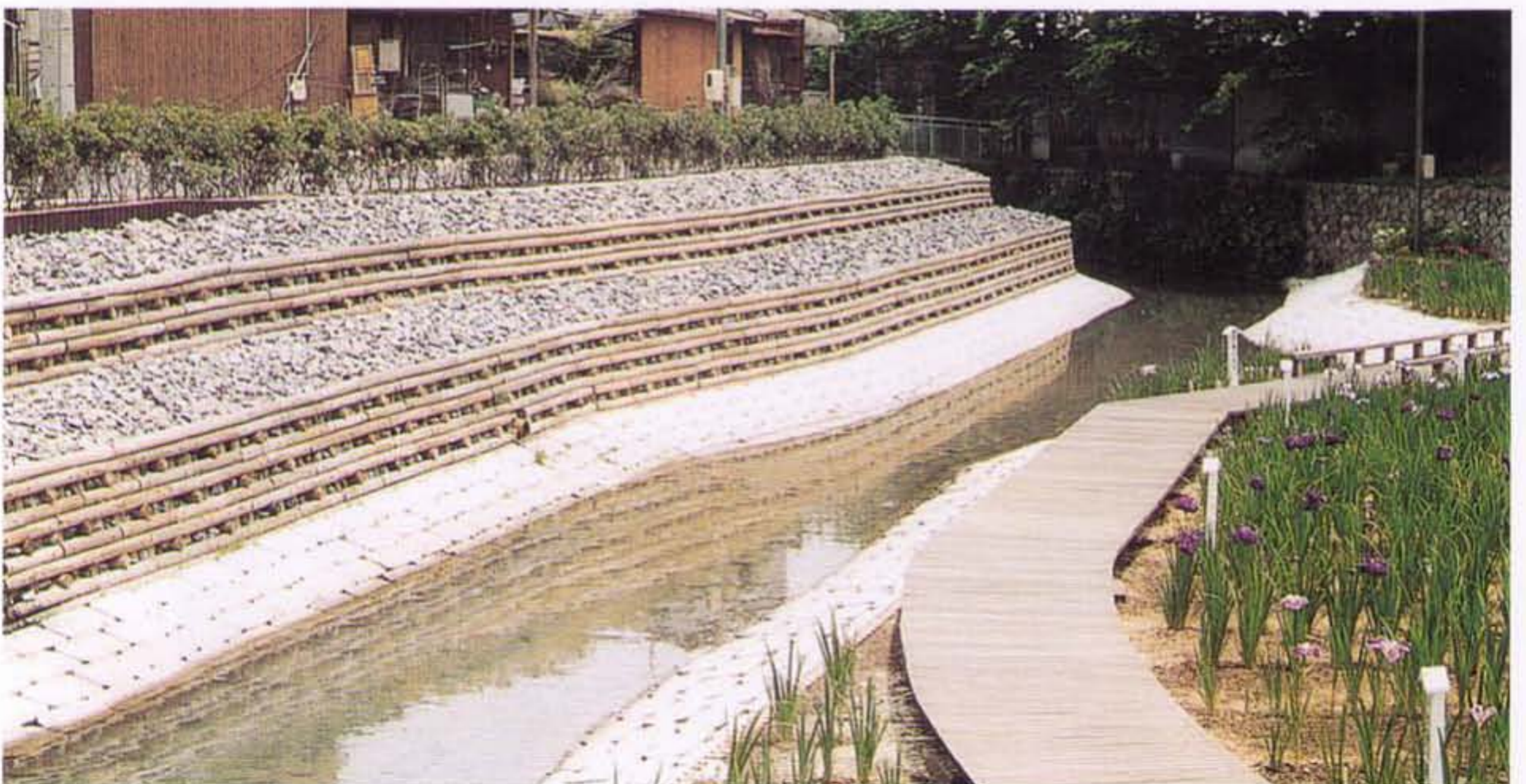
▲河川の護岸に使用したウッドブロック積（施工地／三重県松坂市）
