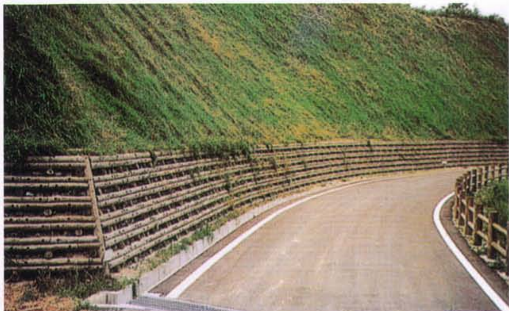
▲土留工に施工したウッドブロック積（施工地／佐賀県浜玉町）
