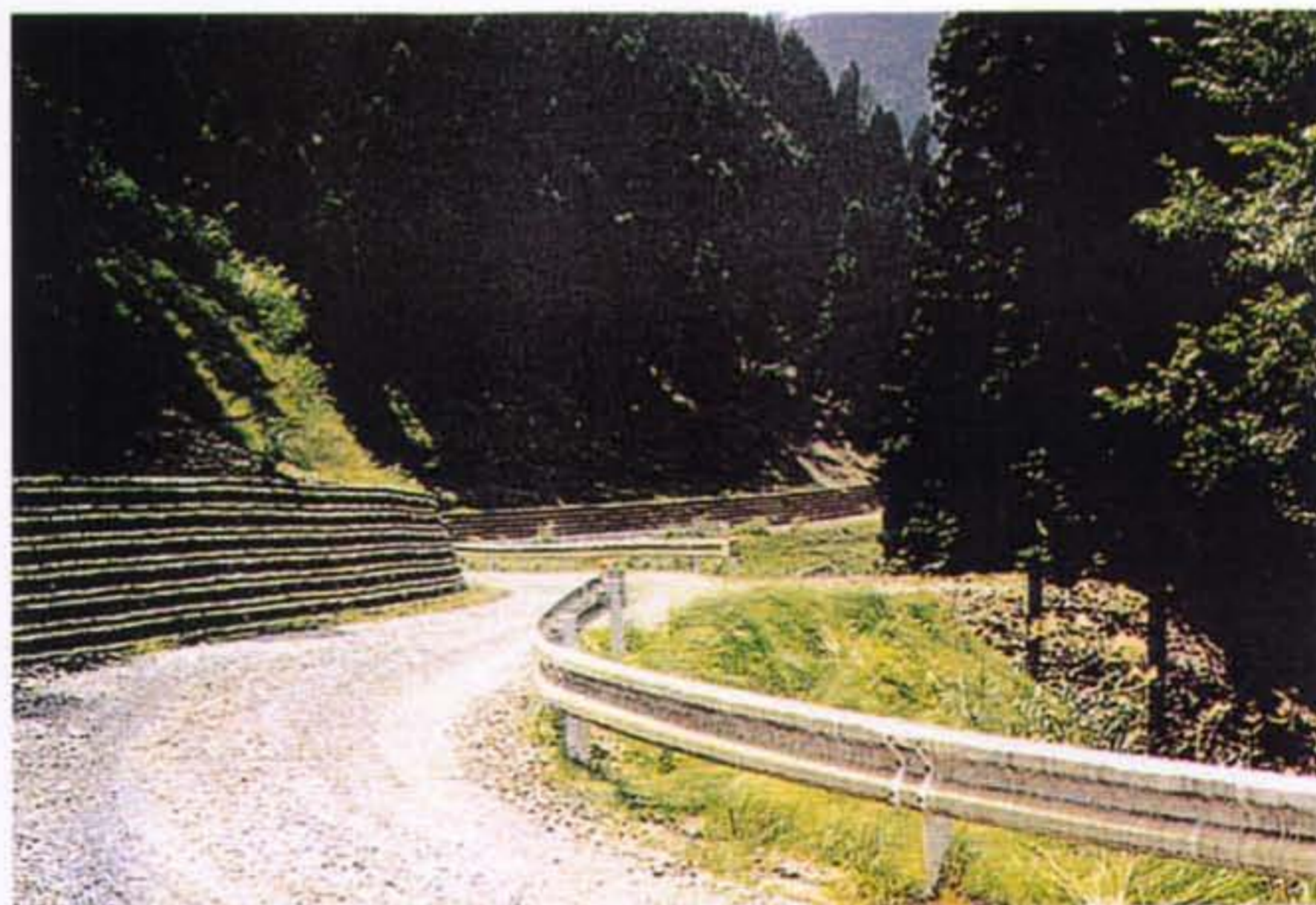
▲土留工に施工したウッドブロック積（施工主体／熊本県）
