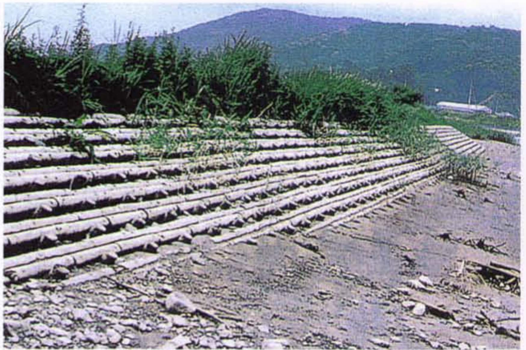
▲河川の護岸に使用したウッドブロック積（施工地／宮崎県串間市）
