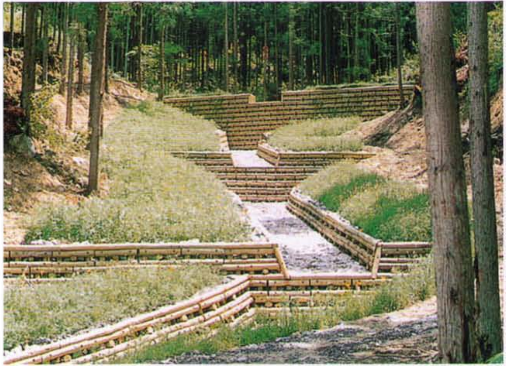
▲多目的保安林事業に使用したウッドブロック積（施工地／愛媛県西予市）
