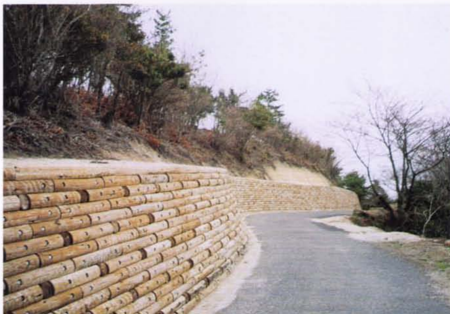
▲公園の土留工に使用したウッドブロック積（施工地／愛媛県伯方町）
