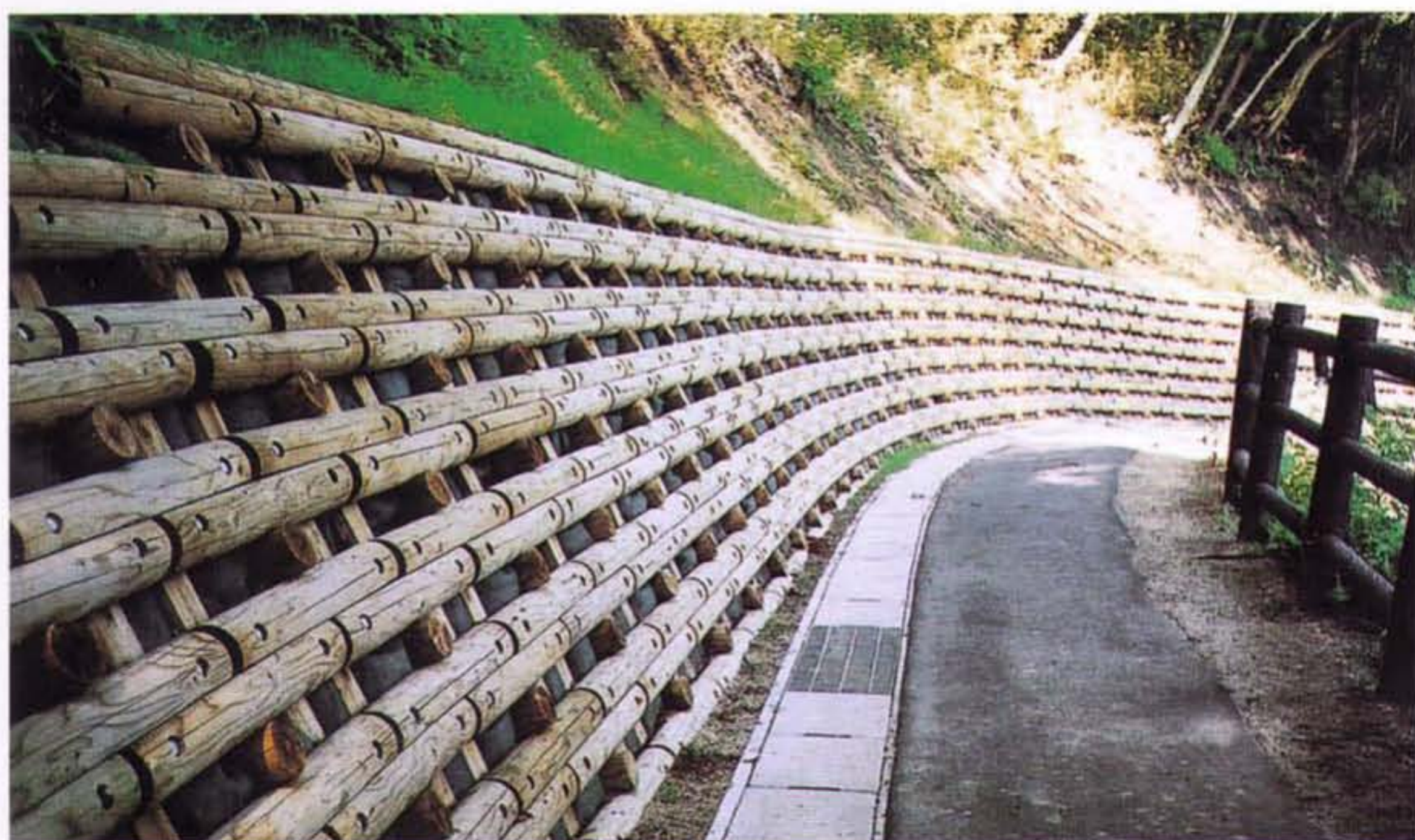
▲公園の土留工に使用したウッドブロック積（施工地／福島県いわき市）
