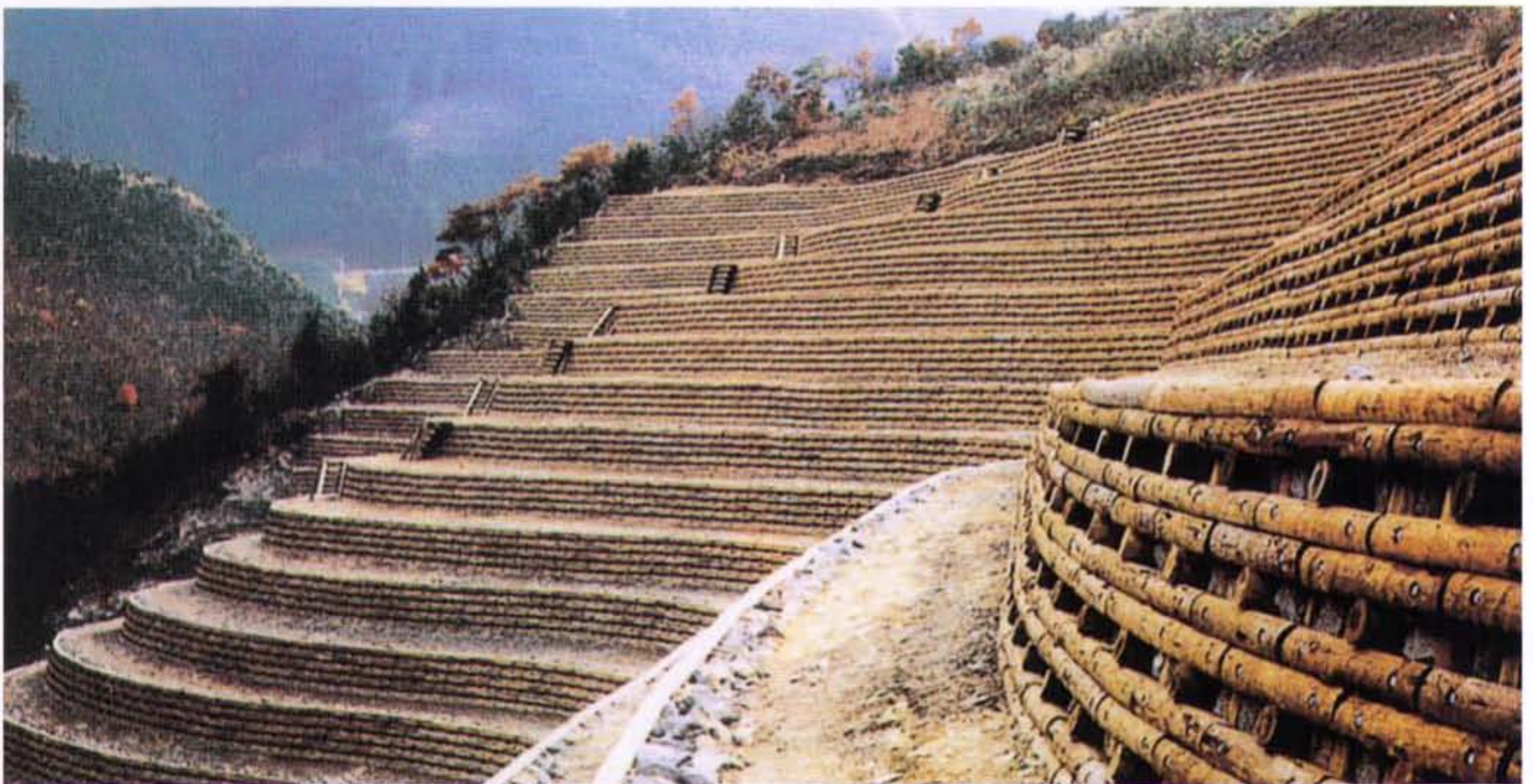
▲山腹工のウッドブロック積（施工地／愛媛県伊予三島市）
