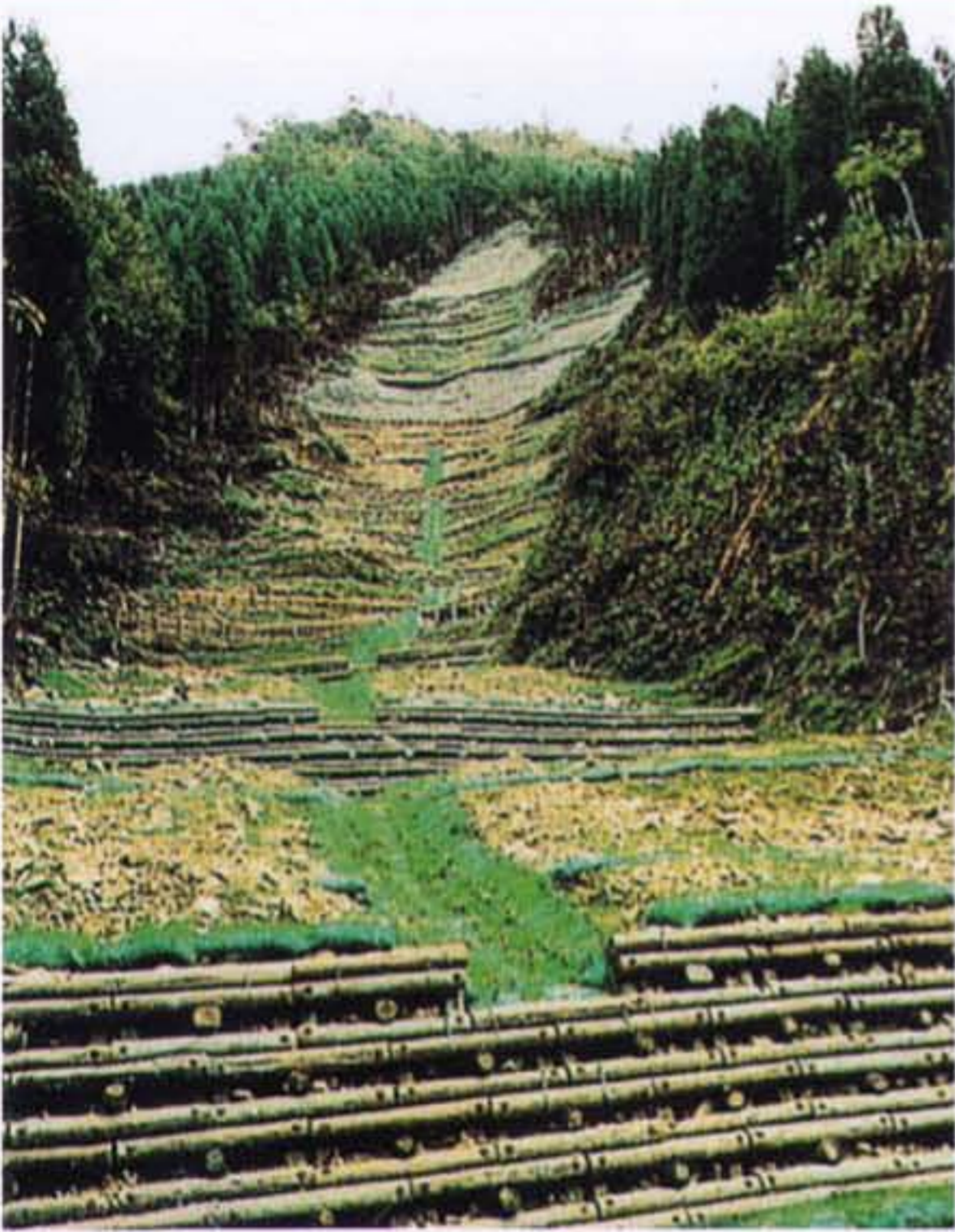
▲木柵工、緑化土のう筋工とウッドブロック積を組み合わせた山腹工（施工地／宮崎県日之影町）
