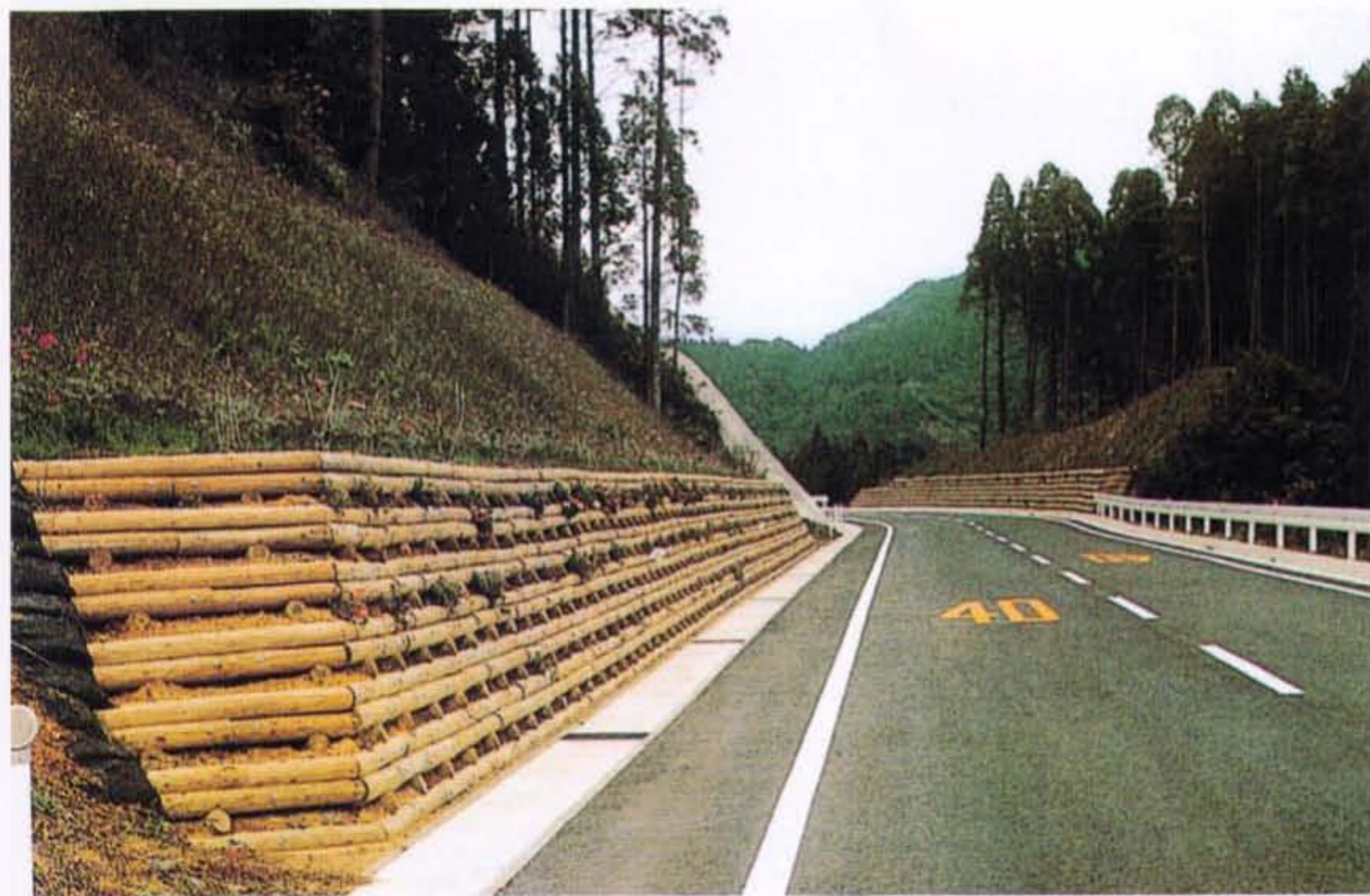
▲土留工に施工したウッドブロック積（施工地／宮崎県串間市）
