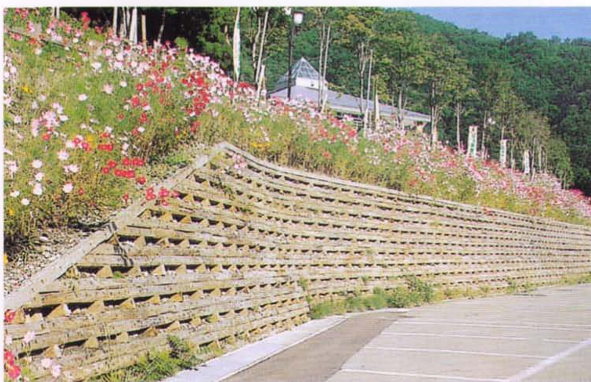
▲宿泊交流施設の法面土留工に使用したウッドブロック積（施工地／岩手県新里村）
