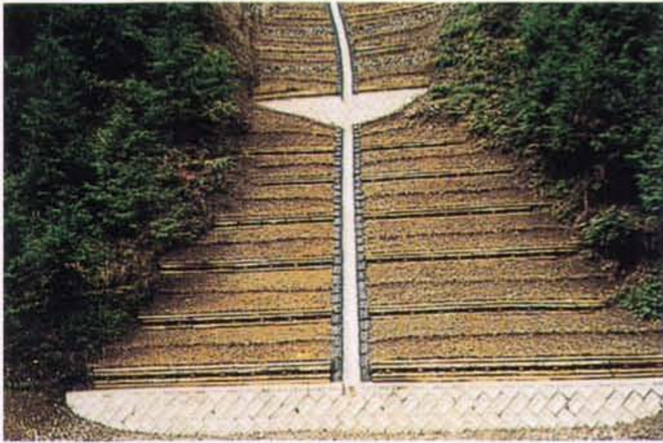
▲山腹工のウッドブロック積（施工地／愛媛県野村町）
