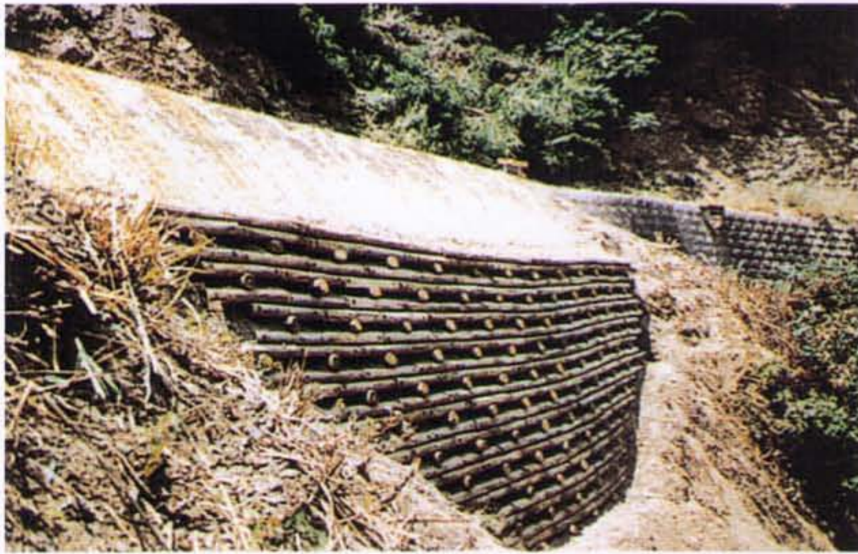
▲土羽下の土留工に施工したウッドブロック積
