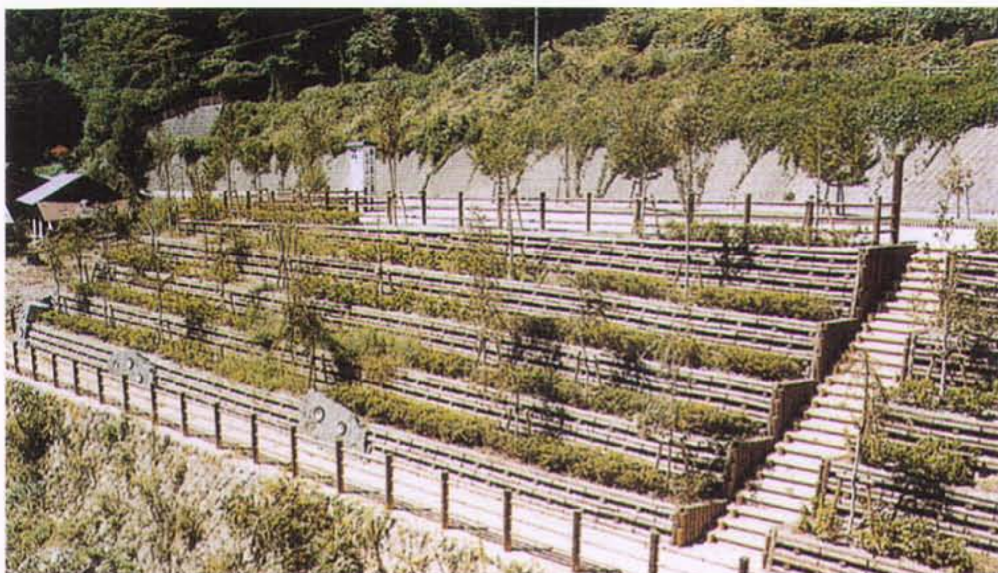
▲環境整備事業に使用したウッドブロック積（施工地／愛媛県広田村）
