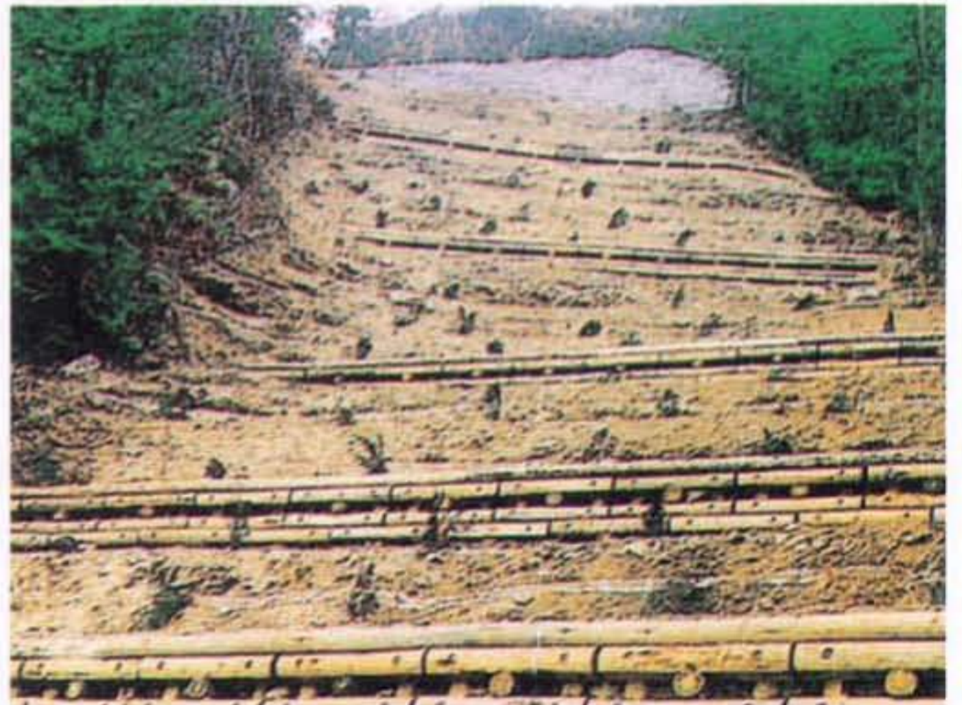
▲山腹工のウッドブロック積（施工地／愛媛県岩城村）
