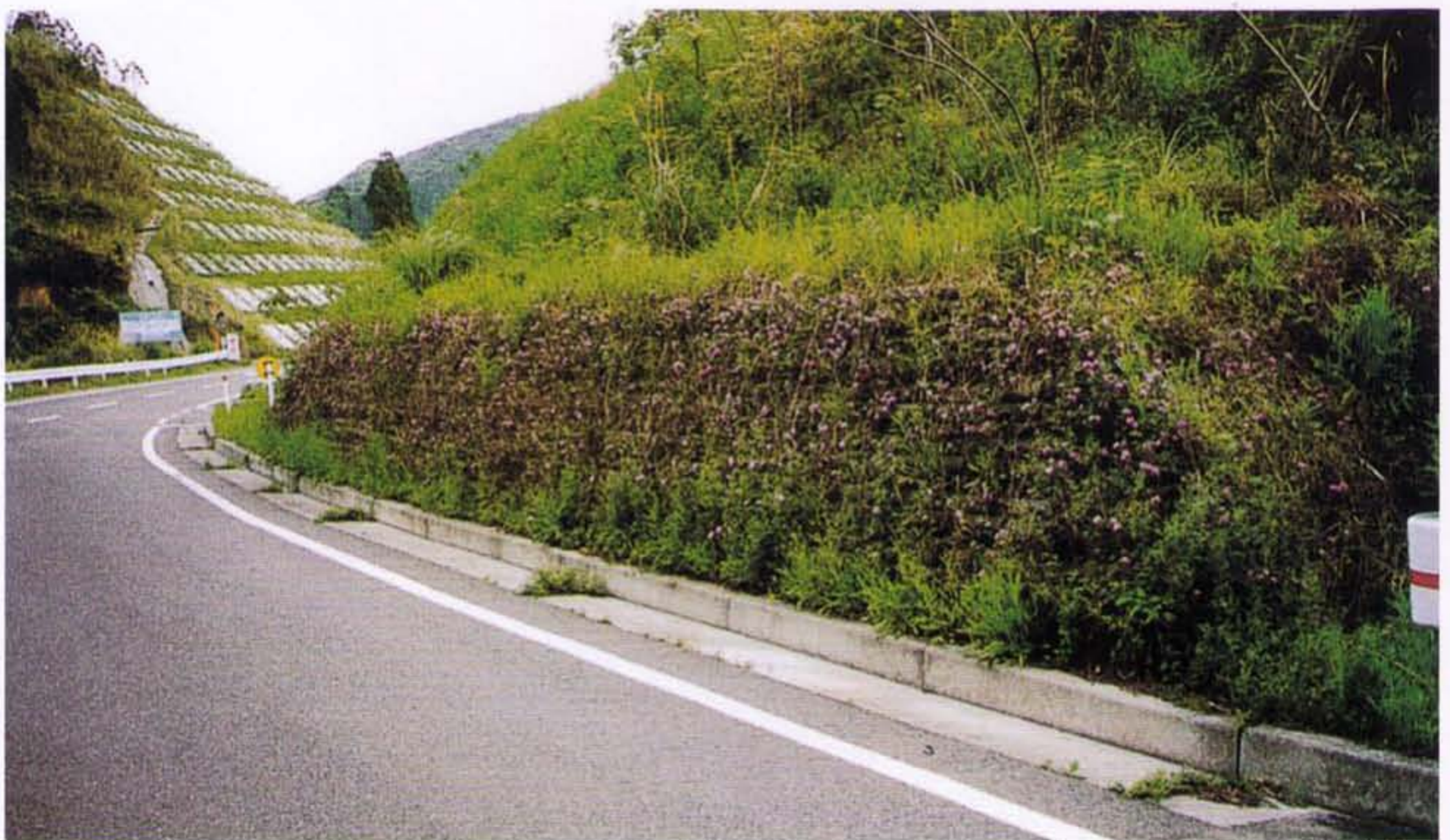
▲国道の土留工に施工したウッドブロック積（コデマリの種子を播種したもの）
