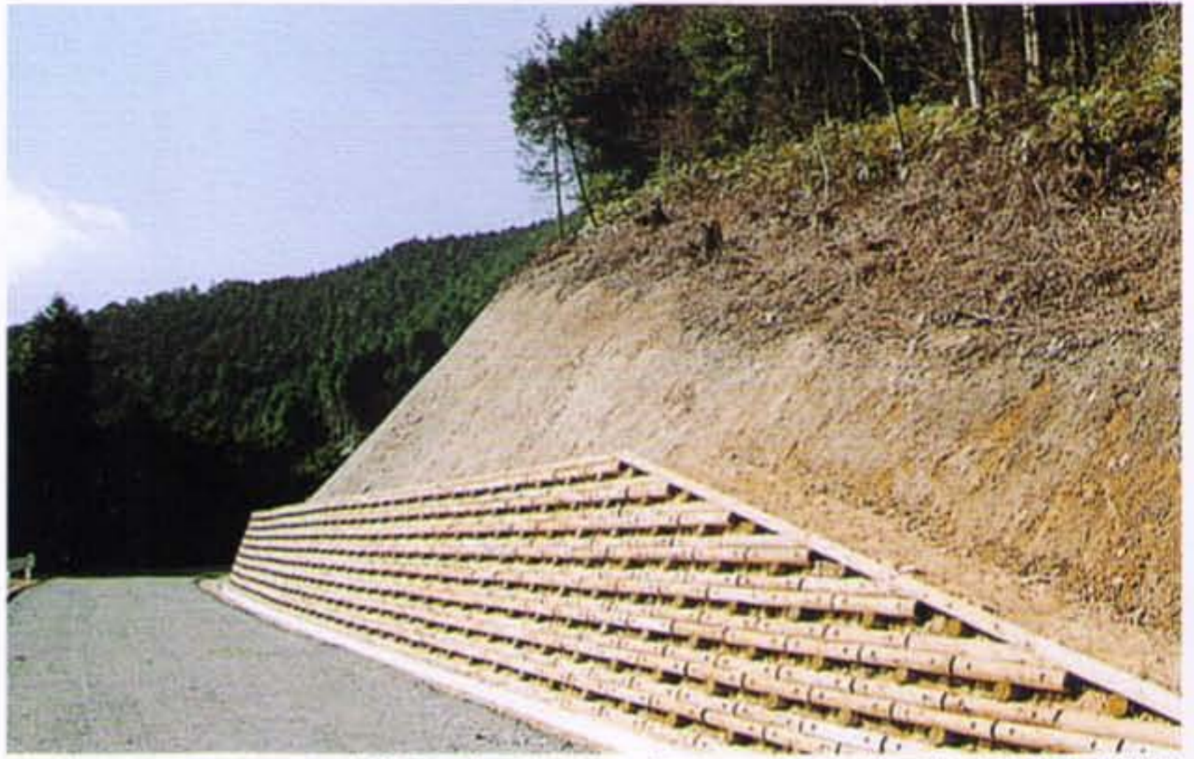
▲土留工に施工したウッドブロック積（施工地／愛媛県小松町）
