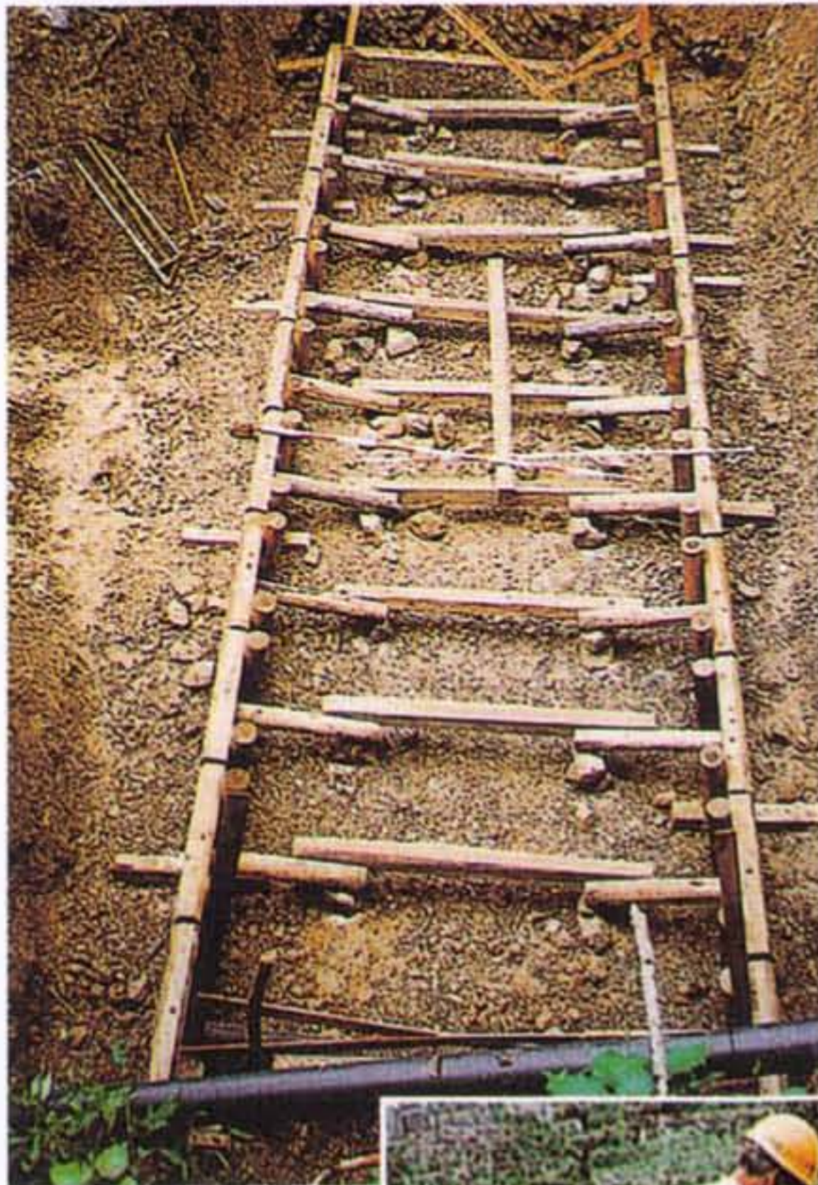
▲谷止工に使用した ウッドブロック （1段目組立状況）
