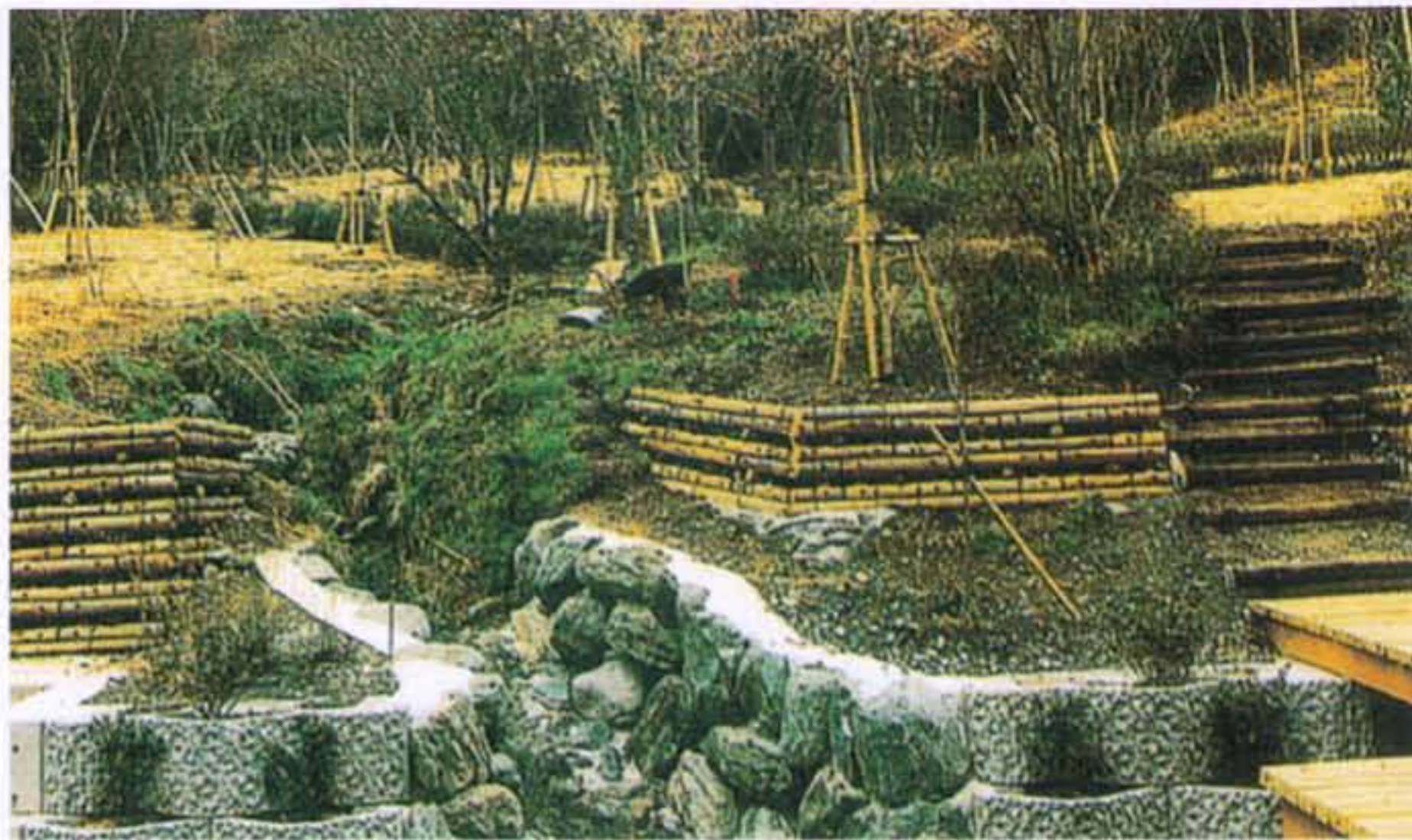
▲公園の土留工に使用したウッドブロック積（施工地／愛媛県久万高原町）
