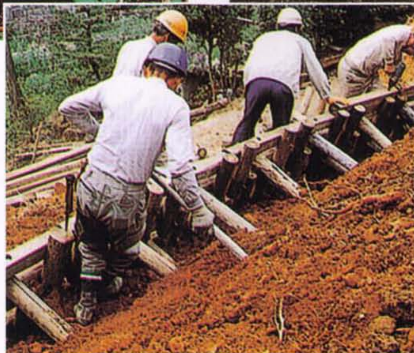
▲谷止工に使用した ウッドブロック （1段目組立状況）
