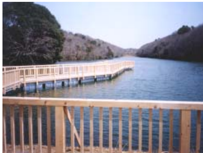
特殊コーティング（モックル処理）した間伐材を使った標識、浮き栈橋
